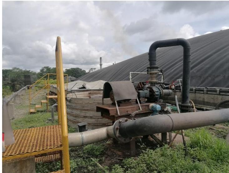
**Figura 22.** Planta de digestión anaerobia de la industria de palma aceitera.
