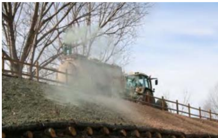
Figura B 13. Aplicación de hidrosiembra en mejora de espacios fluviales (CEDEX, 2011).
