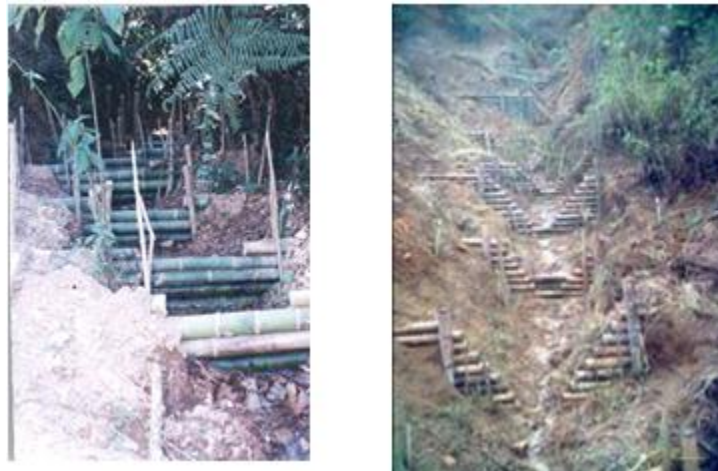
Figura B 12. Ejemplos de aplicación de barreras vivas en cárcavas (Pérez C, 2012).
