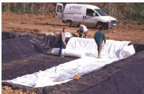
En el proceso de su colocación se debe tener especial cuidado evitando que queden arrugas, zonas sin recubrimiento o bien generar huecos al tensar en exceso el material. Se recomienda además de colocar la geomembrana, colocar sobre esta un geotextil.
