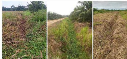
Sumado al crecimiento de vegetación se pueden presentar problemas de obstrucciones por erosión de los taludes o bien por arrastre de sedimentos. Para esto se debe realizar un control de maleza por medio de podas y
