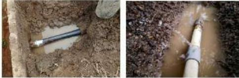
En estos casos se recomienda cerrar la válvula más cercana para poder realizar mantenimiento en el tramo de tubería correspondiente. Es importante que independientemente del tramo de tubería (antes o después de los humedales) donde se trabaje se debe utilizar todo el equipo de protección correspondiente. Evaluar el daño, cambiar los accesorios en caso de ser necesario y revisar el motivo de la posible fuga si es por aumento de presión o golpes.
