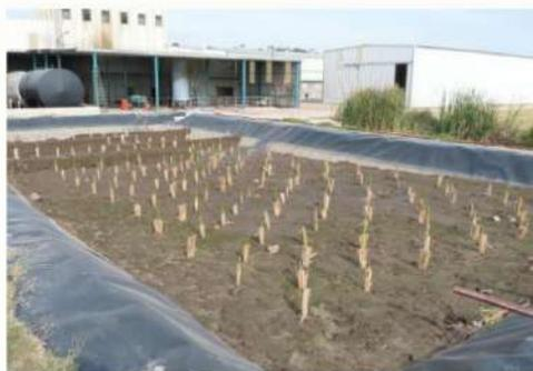
Se recomienda remover la planta y sustituir por otra para evitar afectaciones en el proceso de reducción de contaminantes del sistema, puesto que es importante contar con una buena distribución de raíces en el lecho de filtración.
