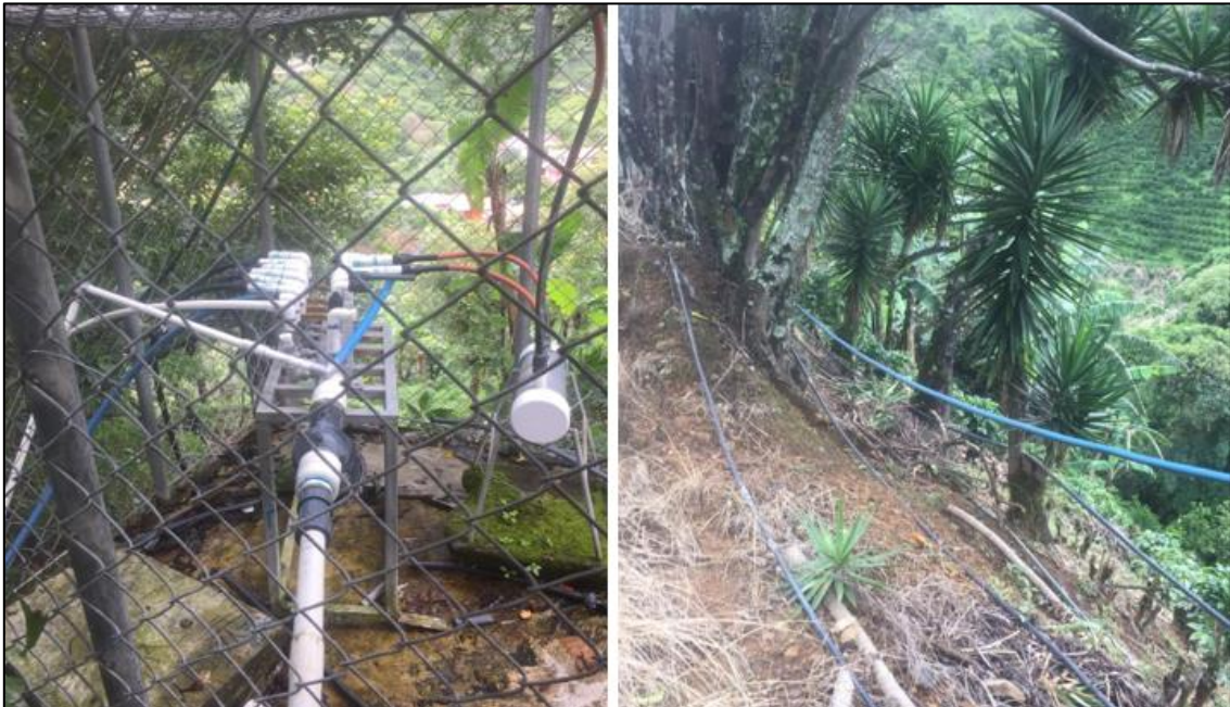
Figura 3-11. Manifold y líneas para la distribución del agua, implementados por la comunidad de El Manzano.
