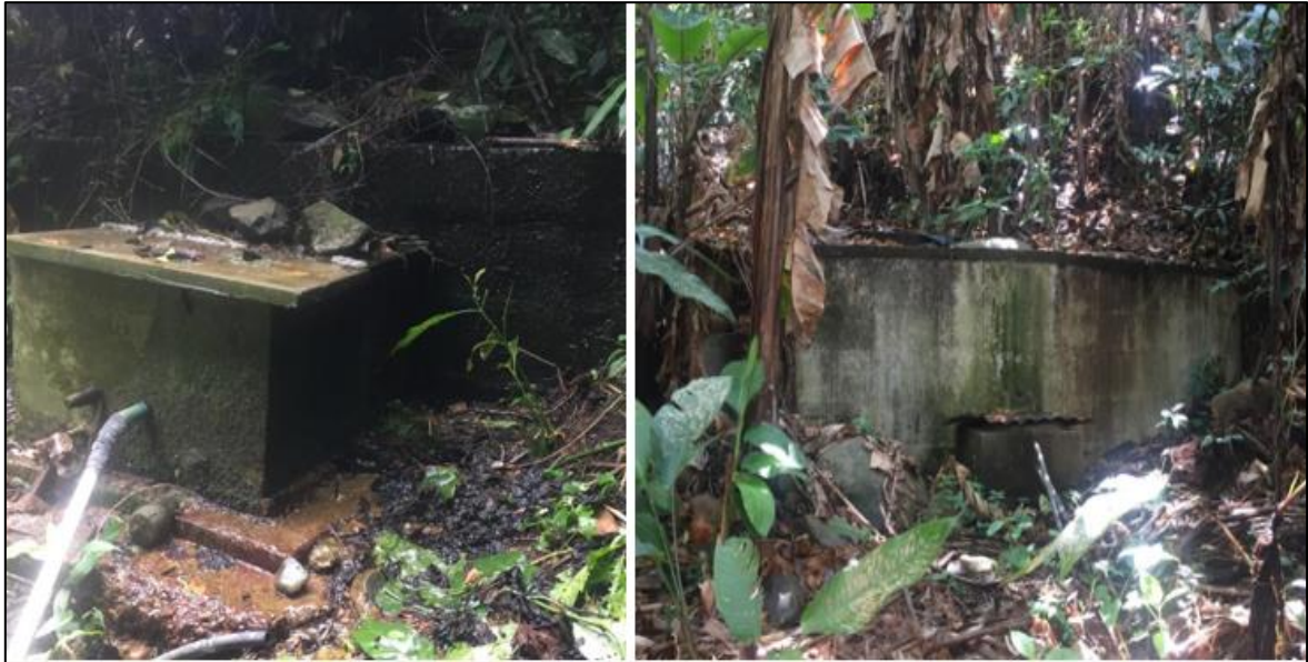
Figura 3-9. Tomas de captación de agua, implementadas a la actualidad por la comunidad de El Manzano.
