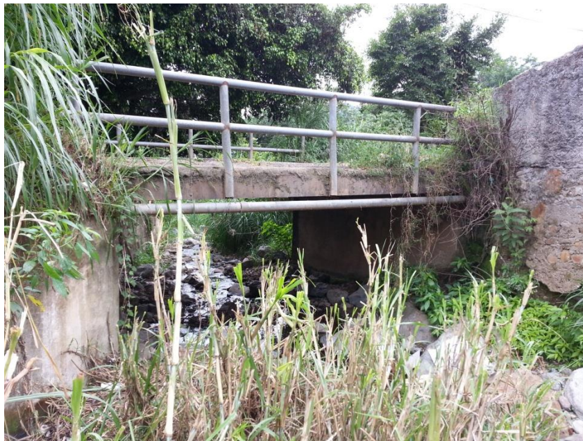
Figura 66. Puente sobre la Quebrada Suárez Estación 141,35.
