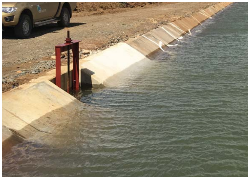
Figura 18. Ejemplo de toma con una sola compuerta ubicada en el DRAT, Canal Sur tramo II.
