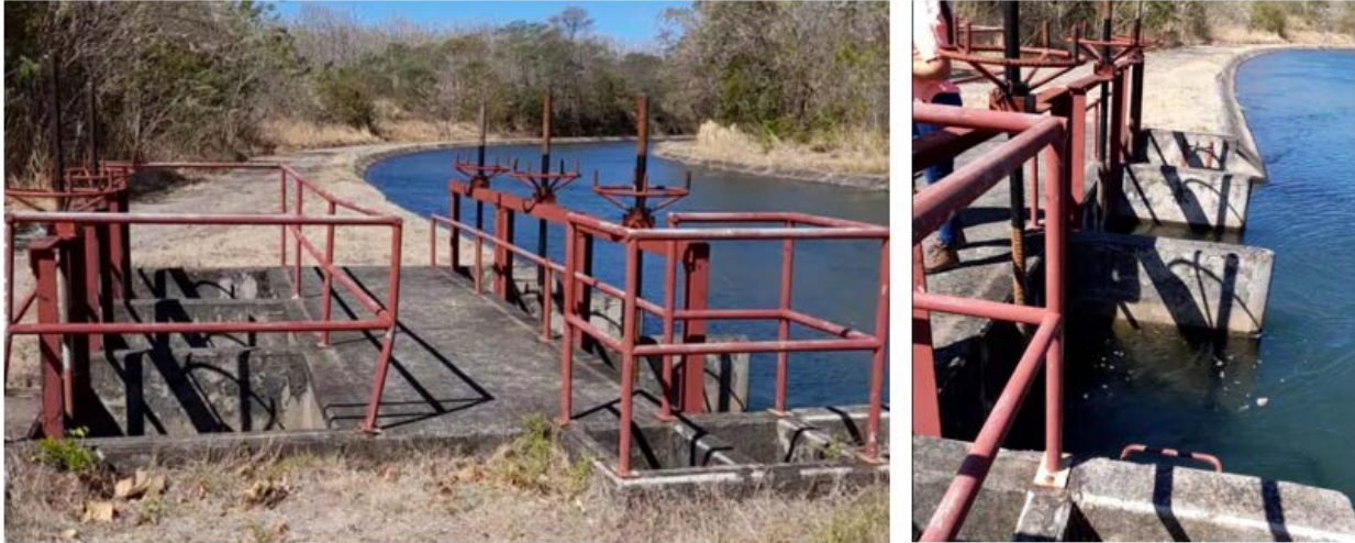
Figura 19. Derivación de canal principal a secundario utilizada en el DRAT, Canal Oeste.
