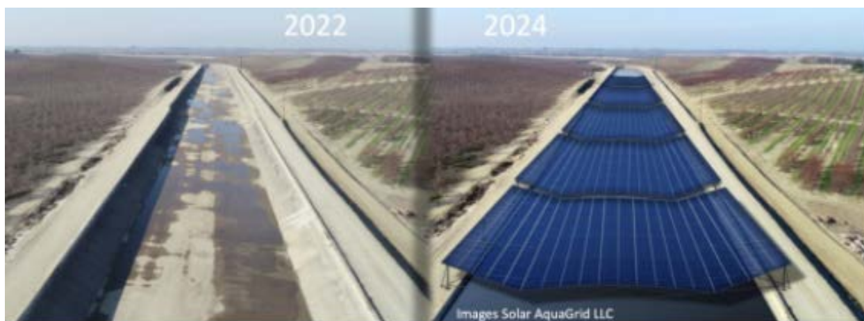
Figura 8. Uso de paneles solares para reducción de la evaporación del agua en canales de distribución de agua (Palou, 2022).
