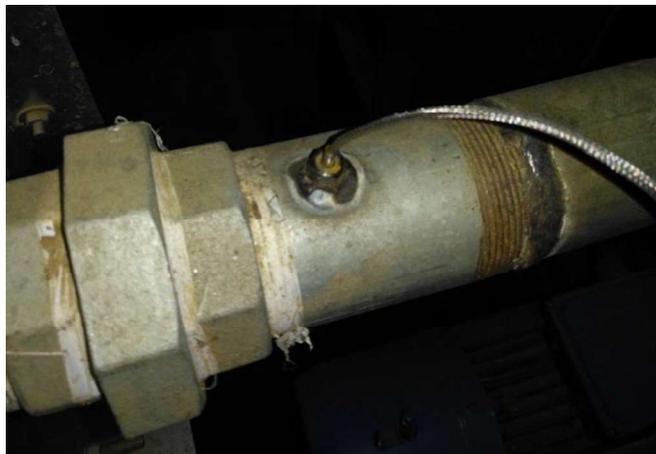
**Figura 17.** Colocación de las termocuplas en las tuberías de vapor.
