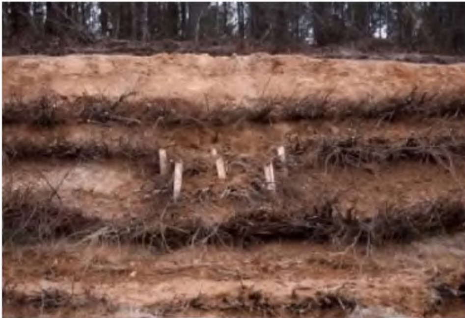
Fajinas en pendiente de moderada a fuerte después de su instalación.
