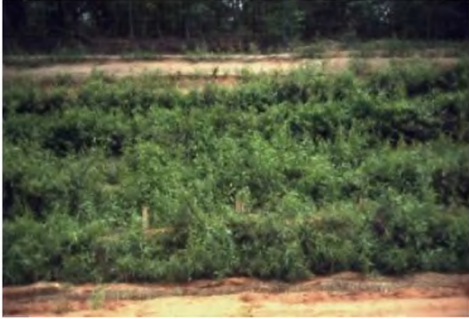
Sistema de fajinas ya establecido con regeneración de la cobertura vegetal.
