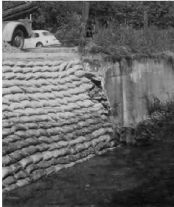
Gavión flexible tipo saco relleno de arena combinado con estacas enraizadas para reforzar una margen erosionada.
