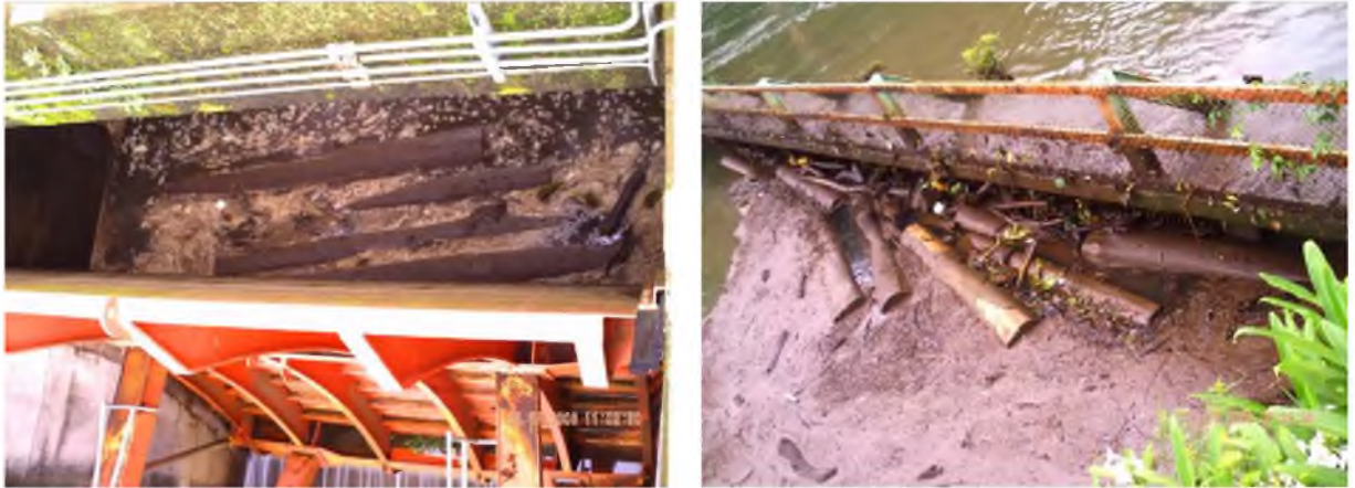
Troncos acumulados en estructuras del embalse Santa Rosa.
