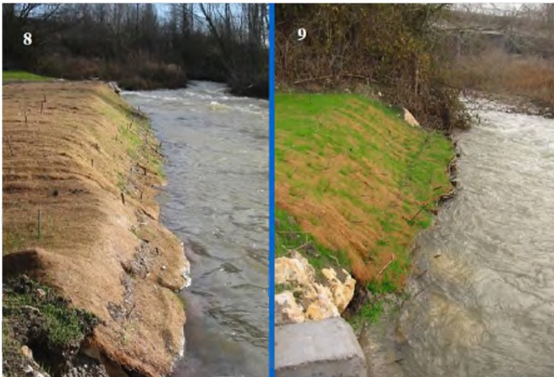
Estabilización de la cobertura vegetal.
