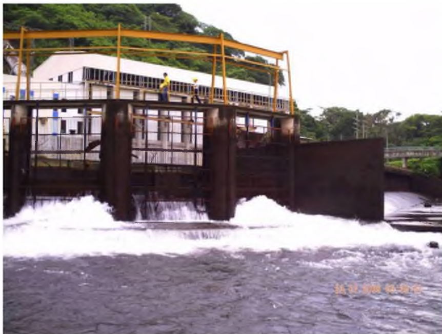
Apertura incompleta de compuertas, en la zona aledaña a la toma de aguas del C.P. Ing. Miguel Pablo Dengo B. en el embalse Santa Rosa.
