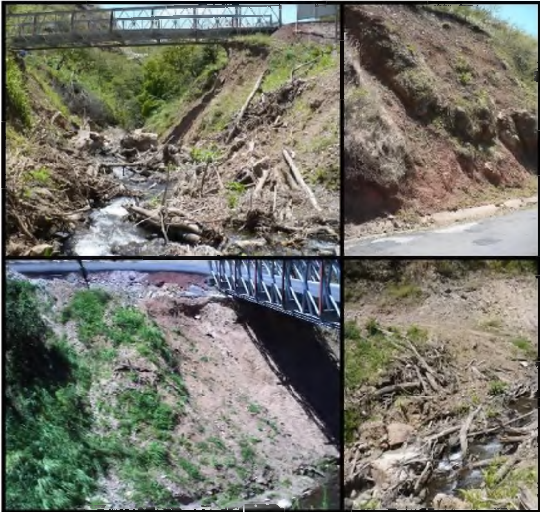
Figura 4.44. Estado de la ribera y el cauce de quebrada Grande en la zona del puente que comunica la comunidad del mismo nombre con Tilarán, Marzo 2009.
