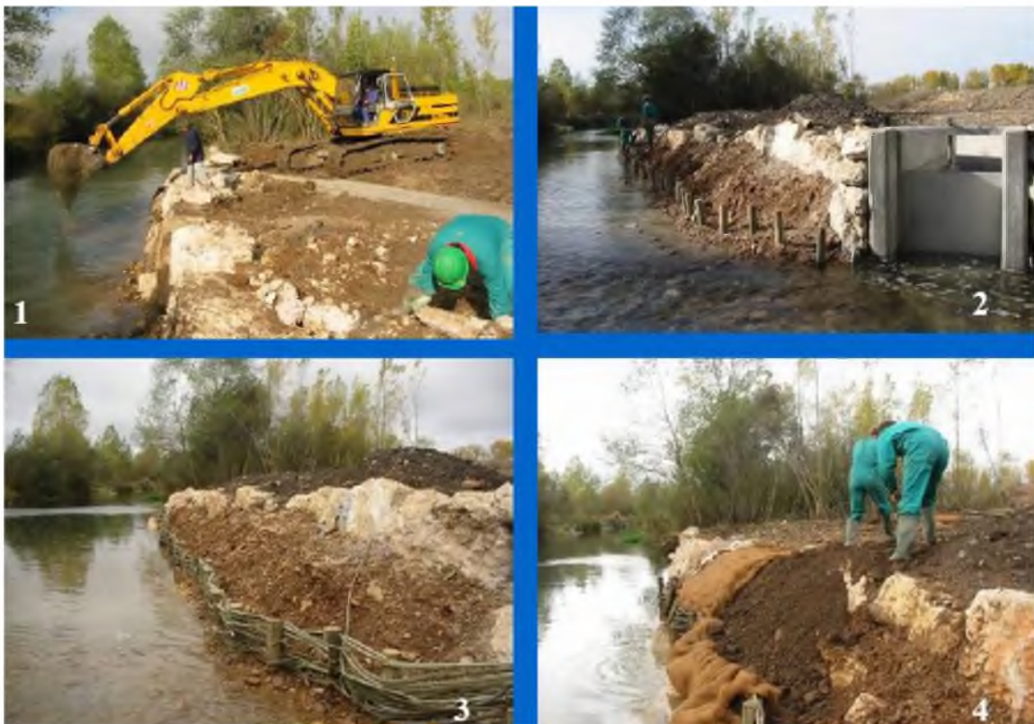
Primeras fases del proceso de estancillado combinado con utilización de geotextiles.
