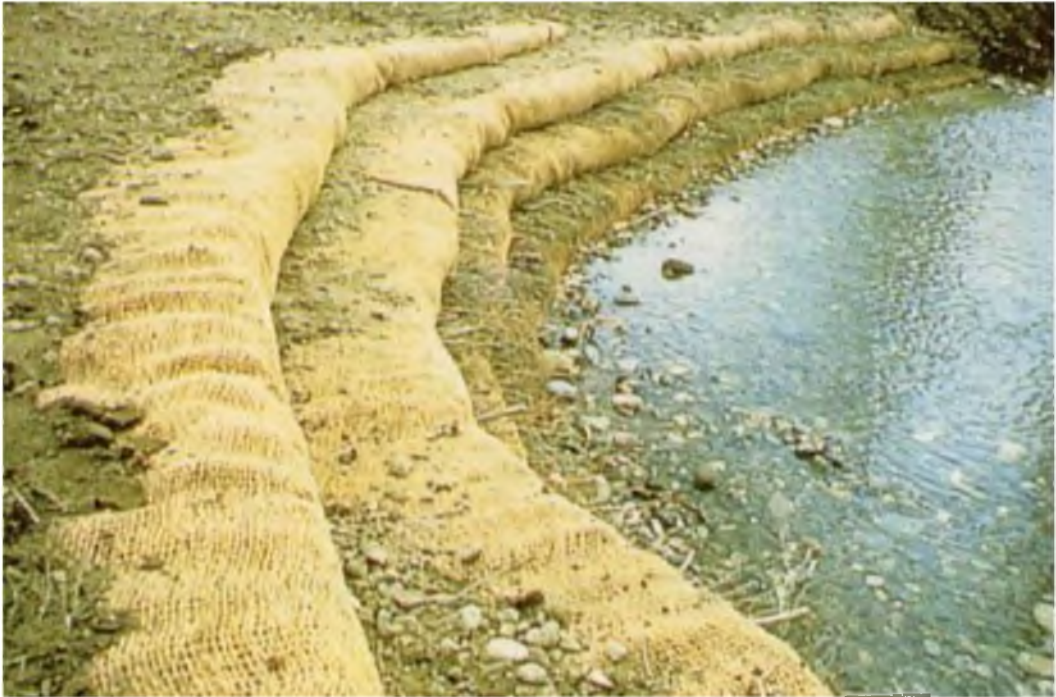
Ejemplo de utilización del sistema de tierra reforzada en combinación con estacas de vegetación.
