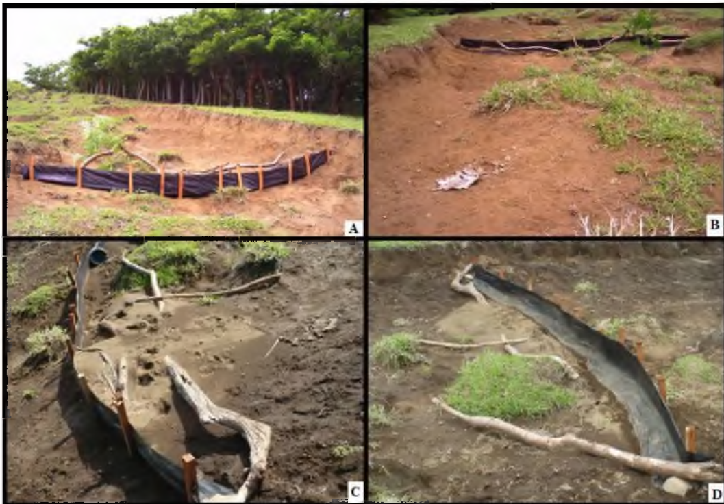
Figura 4.39. Parcela experimental IE ESTU. A, B) Vista de la parcela experimental donde se aprecia la formación de la cárcava. C) Acción de la geomembrana, retención del suelo erosionado en la cárcava. D) Geomembrana limpia para la cuantificación de nuevo material erosionado.
