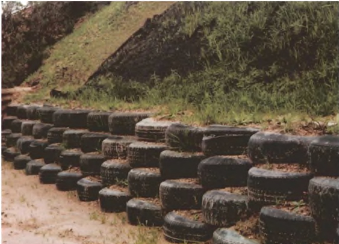
Ejemplo de barrera de retención utilizando llantas y geomembranas.
