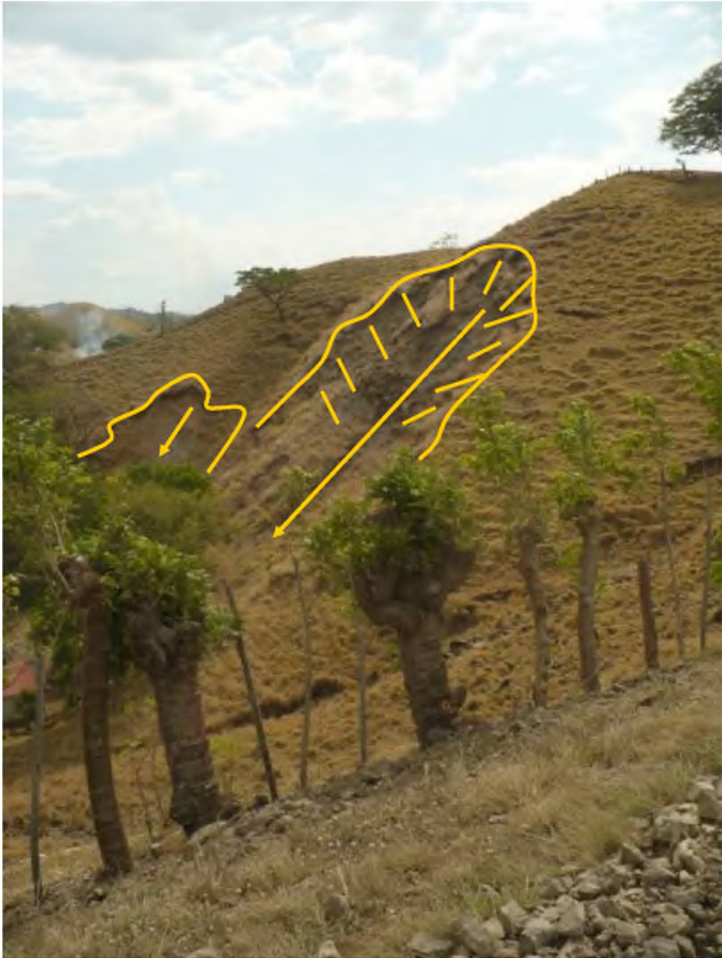
Figura 4.47. Deslizamiento presentado cerca del cauce de la quebrada Chiquiro en su margen derecho.
