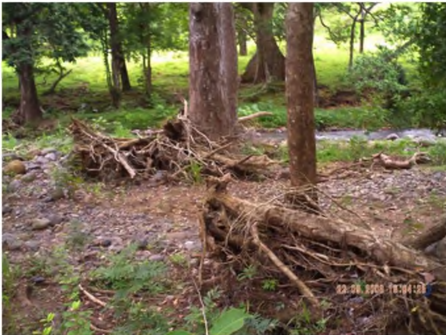
Figura 4.50. Troncos, arena y piedras, acumulados en el cauce de quebrada Grande aguas arriba de su confluencia con el río Santa Rosa.
