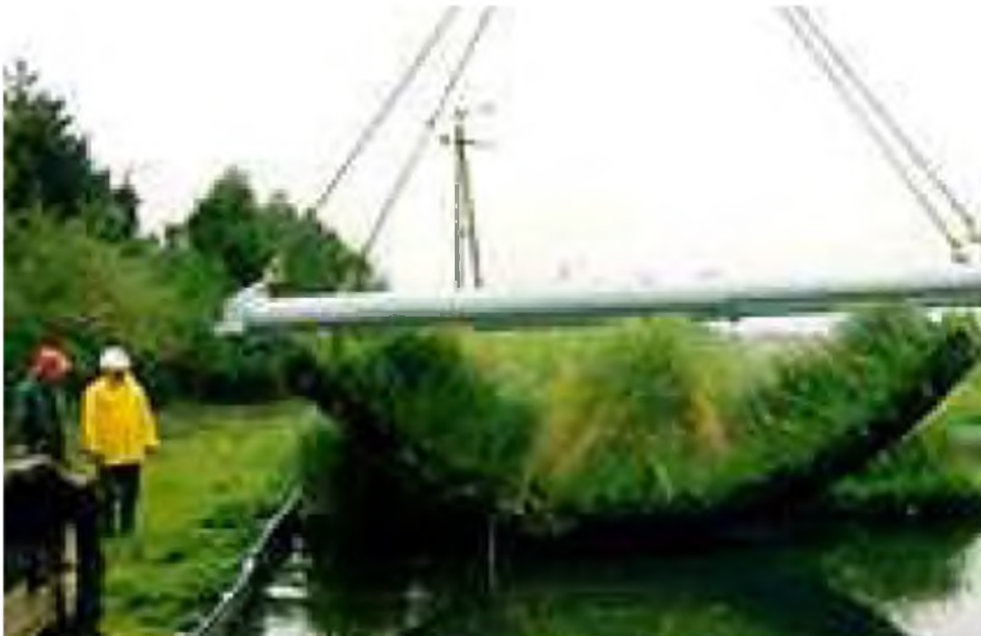
Gavión pre vegetado durante su instalación.
