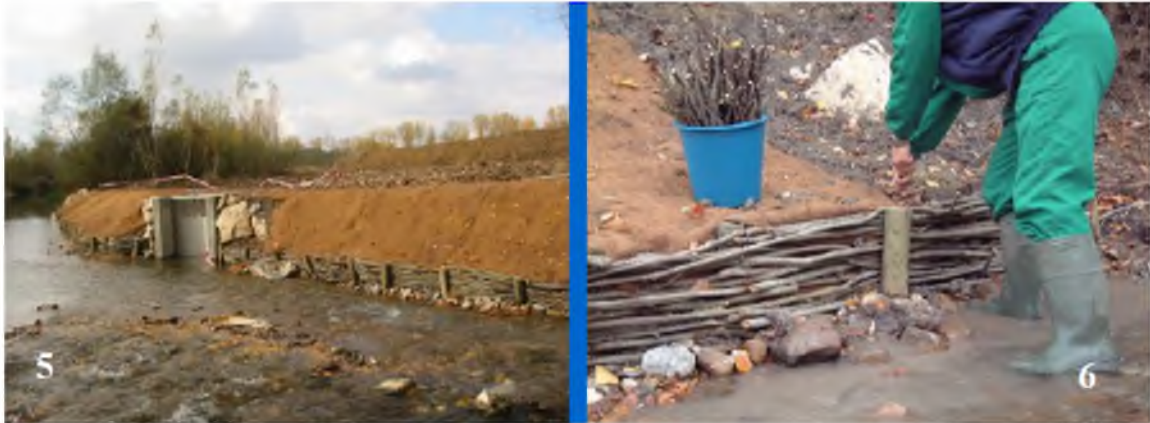
Estanquillado del margen del río.
