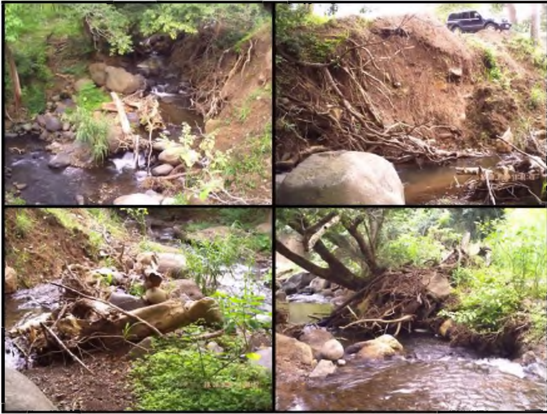
Figura 4.46. Zona inestable, con riesgo de movimiento en masa en la ribera de quebrada Qesera aledaña al puente de la ruta Tilarán –Líbano.
