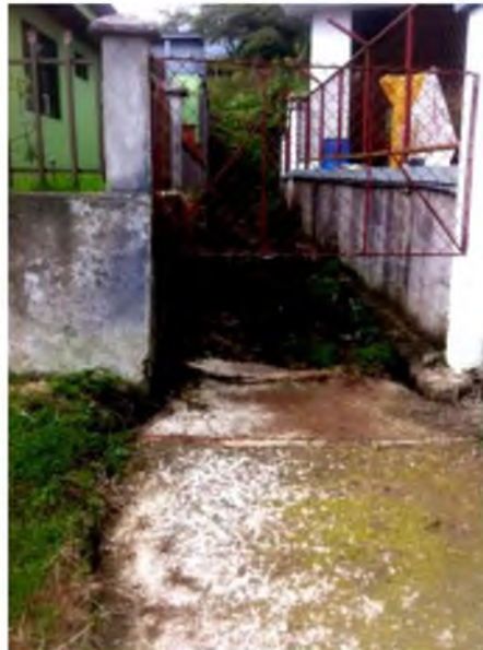
Figura 4-6. Salida del canal de desvío de aguas de Oratorio.
