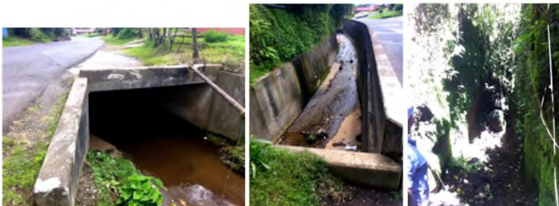
Figura 4-9. Alcantarilla a nivel de la entrada (izquierda), Alcantarilla a la salida (centro), Tramo de la quebrada con problema de socavación (derecha) de Chayotillo.
