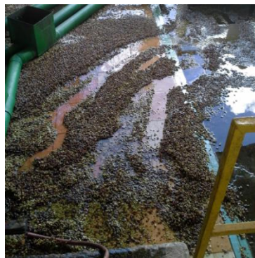
Figura 16. Fuga provocada por obstrucción de las tuberías
