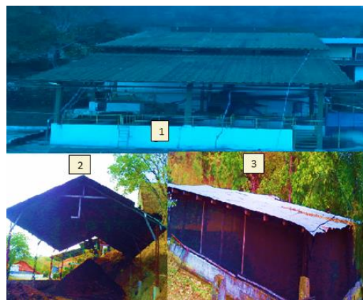
Figura 21. Techos para la captación de agua de lluvia
