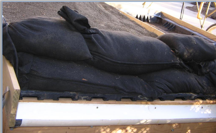
Ilustración 0-10 Conformación de muro de contención
