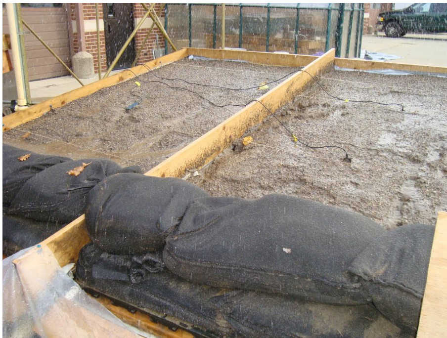
Ilustración 0-5 Prueba: Tratamiento Cemento+Arena, 15%, Suelo Suelto
