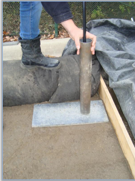
Ilustración 0-9 Proceso de compactación
