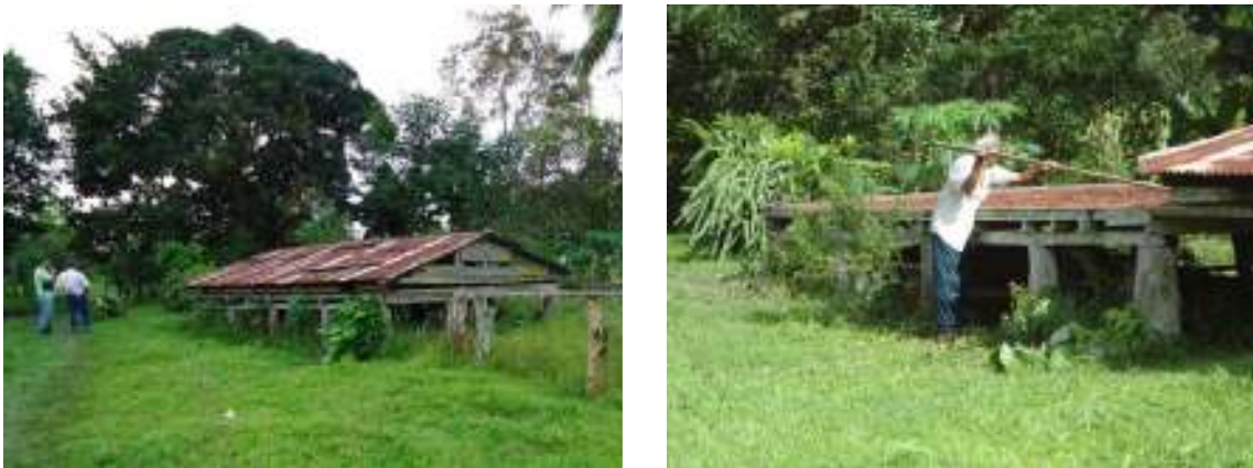
Figura 5.5 Secador de techo corredizo en las Delicias de Upala
