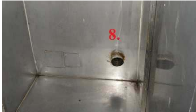
Figura 5.37 Ducto de recirculación de aire (8)
