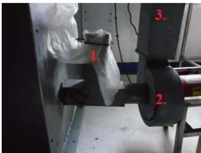
Figura 5.34 Entrada e impulsión de aire ambiente
