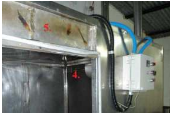
Figura 5.35 Ventilador (4), resistencias (5) y botonera
