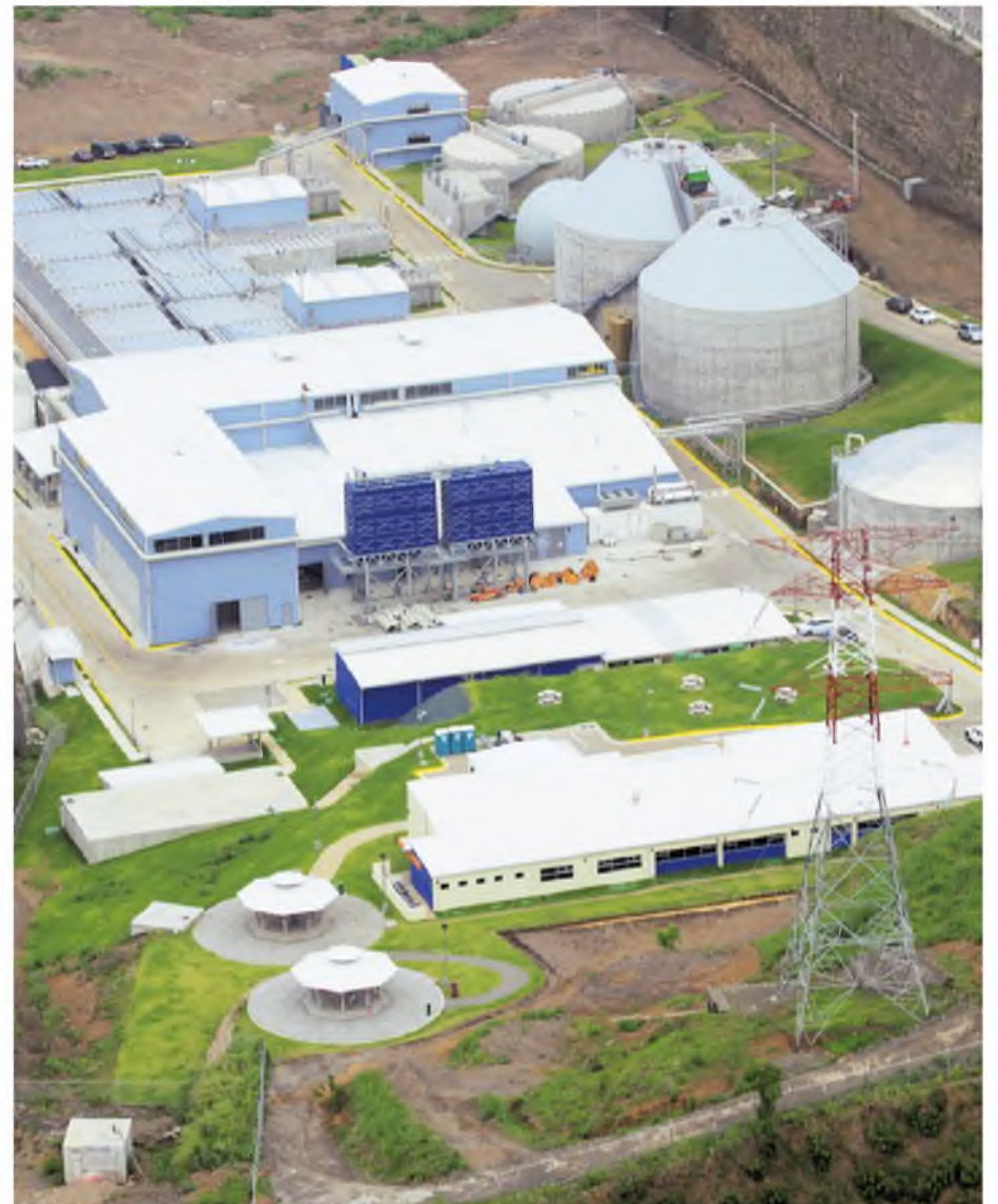
La planta Los Tajos, en La Uruca, trata entre 480 y 500 litros de aguas residuales por segundo. La expectativa es que entre el 2020 y 2022 el caudal aumente hasta llegar a los 2 800 litros por segundo, la capacidad total de la planta. Foto cortesía de AyA.
