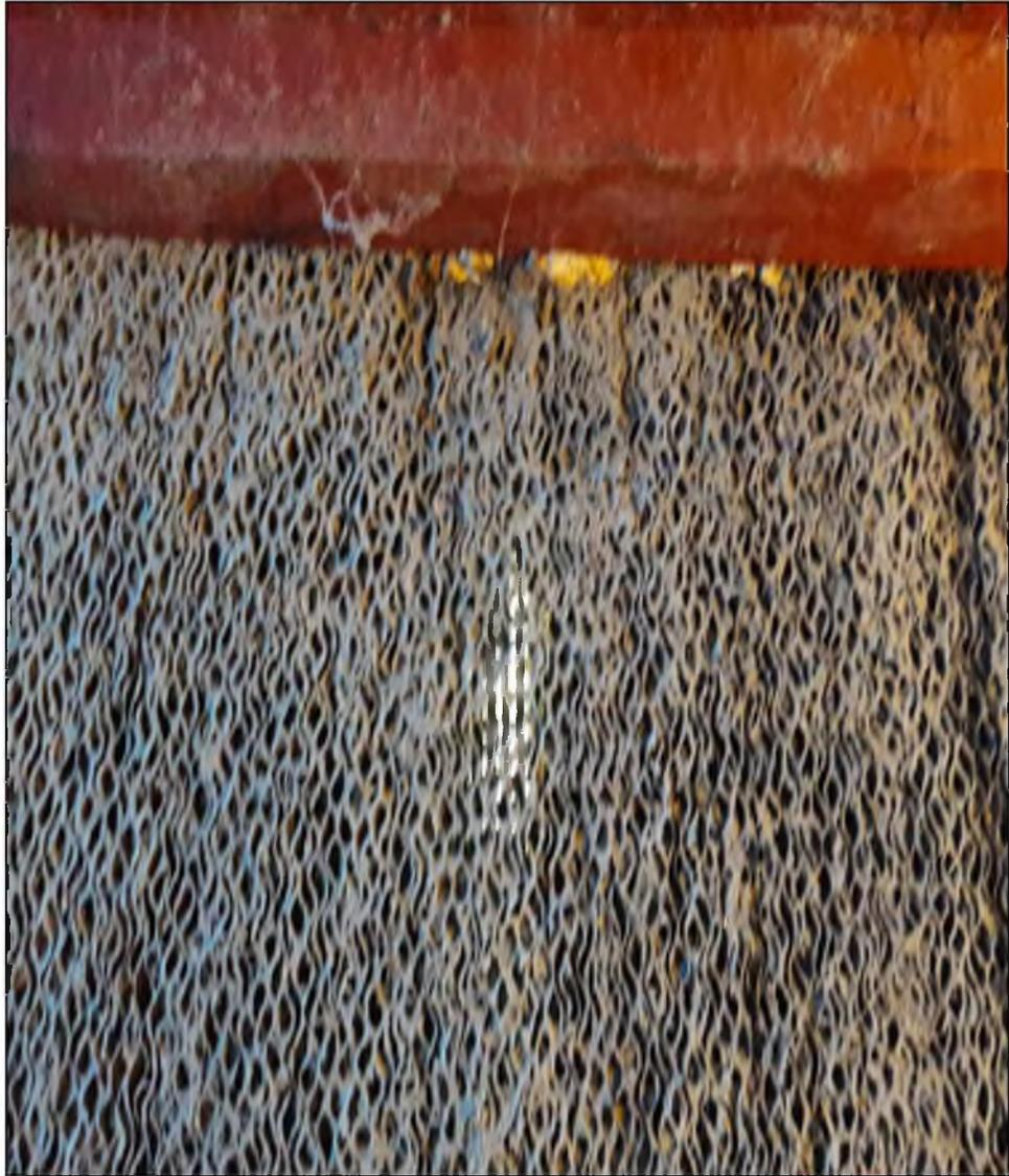
Figura 17. Suciedad en el sistema de enfriamiento
