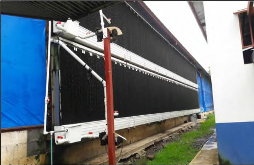
Figura 6. Paneles del sistema de enfriamiento evaporativo
